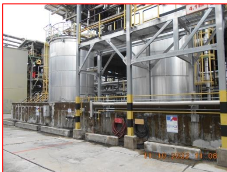
ภาพที่ 2.2-33 Band Wall ป้องกัน Tank pit
