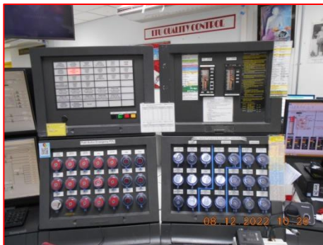
ภาพที่ 2.2-31 ระบบ Interlock System ควบคุมการจ่ายสารเข้าสู่ระบบ
