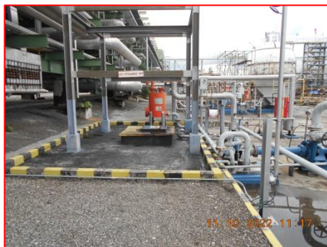
ภาพที่ 2.2-21 Slop Oil Tank รวบรวมเศษน้ำมันจากหน่วย CPI
