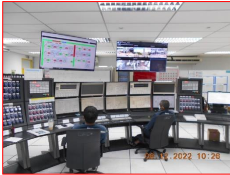
ภาพที่ 2.2-29 Distributed Control System (DCS) สำหรับควบคุมการทำงานของระบบ
