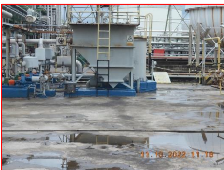
ภาพที่ 2.2-3 ระบบบำบัดน้ำเสียเบื้องต้น (Corrugated Plate Interception; CPI)
